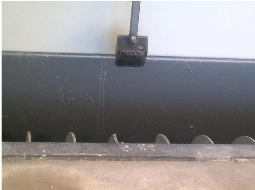
Dal punto di caduta combustibile del trasportatore a catena esistente, senza nessuna modifica di quest'ultimo, verrà fornito un canale verticale in acciaio ispezionabile con interposta la serranda tagliafuoco omologata secondo le norme antincendio internazionali.
