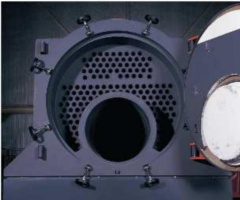
*Esempio caldaia superiore a 3 giri con pulizia pneumatica (2600 kw Tlr Falzes)*
