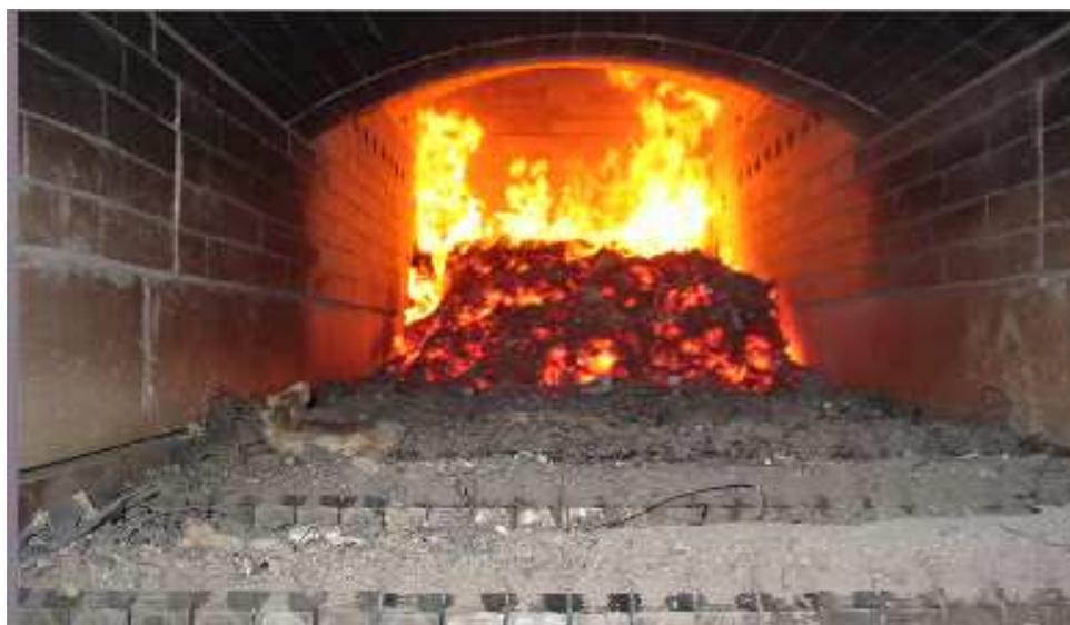
Anche la camera di combustione stessa contribuisce a un processo di combustione completo ed ottimale. E composta da una volta intermedia con due zone separate (zona di combustione primaria e secondaria), collegate l'una all'altra tramite uno canale di flusso.
