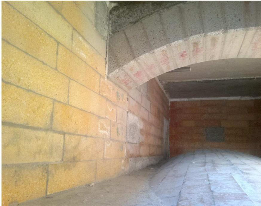
I volumi di entrambe le camere di combustione sono dimensionati in modo tale da garantire il necessario tempo di permanenza del gas di combustione. I ventilatori indipendenti e a velocità variabile continua consentono l'impostazione di diverse modalità di combustione in entrambe le zone.
