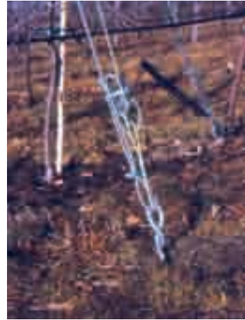
Fig. 28 - L'occhiello dell'ancora deve sporgere dal terreno
