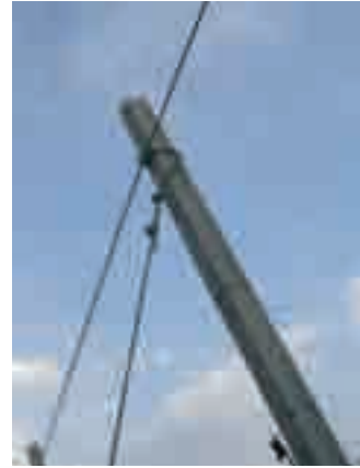
Fig. 26 - La fune di ancoraggio va fissata a circa 50 cm dalla sommità
