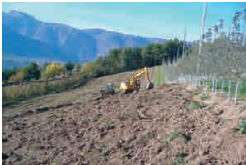
Fig. 17 - Nei terreni in pendenza la lavorazione può essere effettuata con l'escavatore
