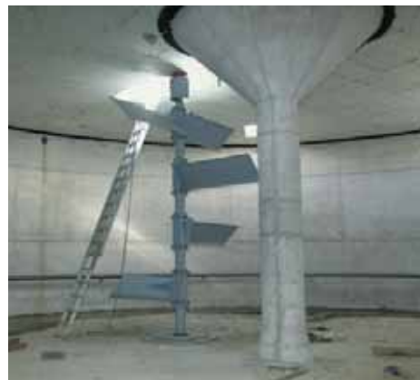
Fig. 5 - Miscelatore ausiliario a pale
