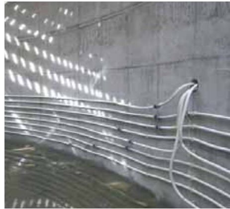
Fig. 2 - 3 - Digestore coibentato e riscaldato con rete di tubazioni interne
