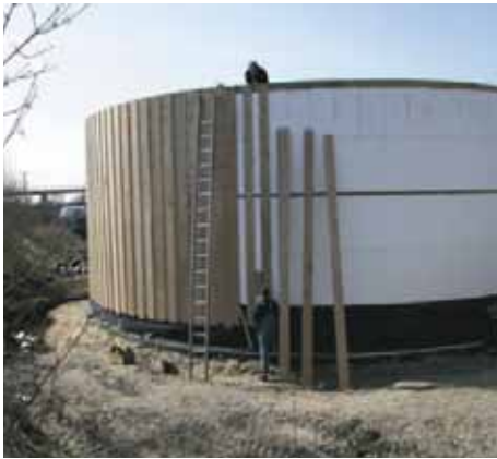
Fig. 2 - 3 - Digestore coibentato e riscaldato con rete di tubazioni interne
