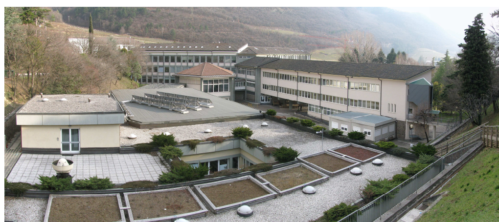
Vista dell'ala Nord Ovest del complesso scolastico
