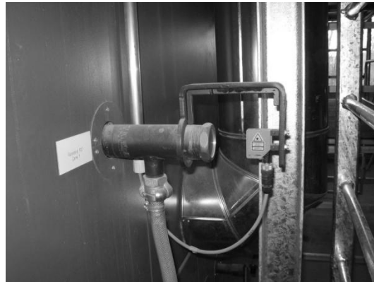
Fig. 3 Dispositivo di controllo ottico del regolatore di livello della camera di combustione
