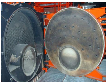
Fig. 1 Aprire la porta della caldaia
