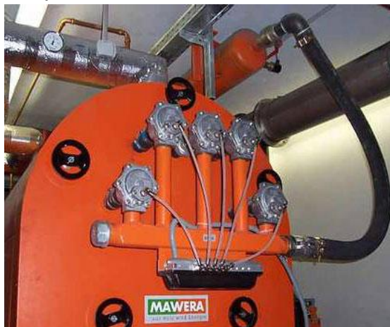
Fig. 6 Caldaia con pulizia automatica
